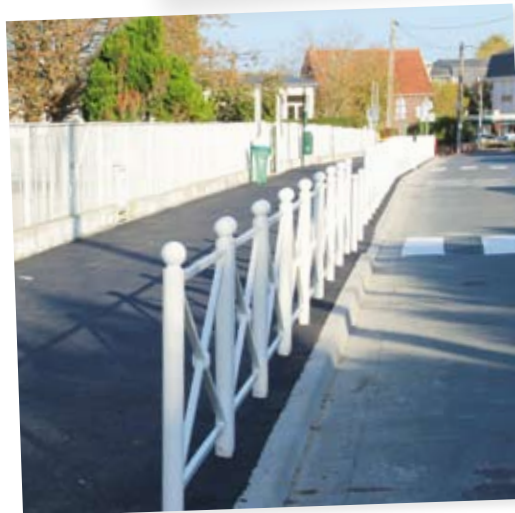
Le trottoir de l'école Jean Jaurès a été refait, avec l'adjonction de barrières de sécurité
