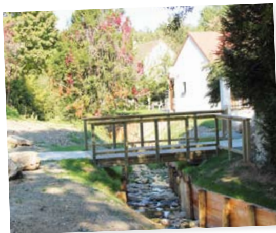
Aménagement complet des deux ponts du ru de la Fontaine de Villiers et de leurs abords
