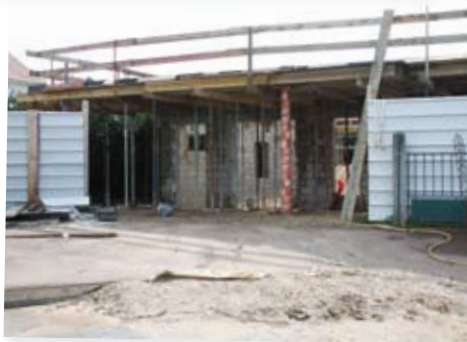
Les travaux du RAM ont débuté au cours de l'été 2017
