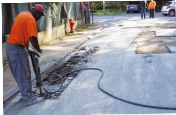
Des travaux provisoires de réfection ont été effectués rue Édouard Branly en attendant la rénovation complète de la rue
